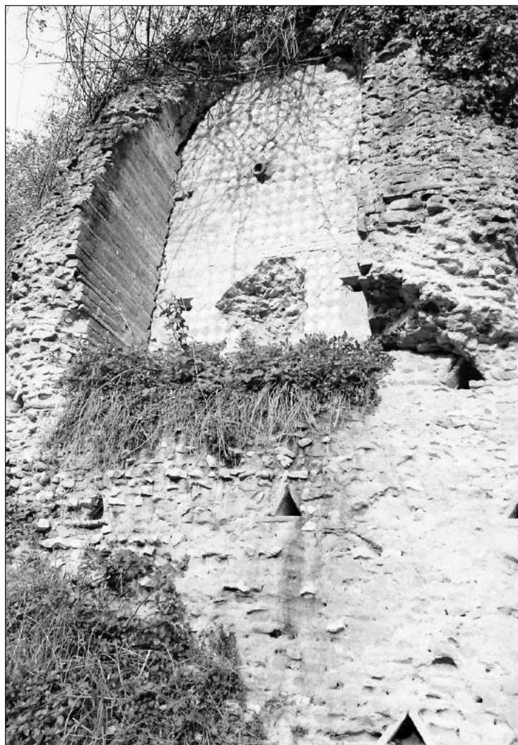
Villa di Santo Stefano. Muraglione di sostruzione
