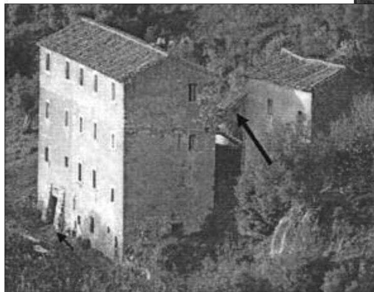
Fig. 7 - ARCHETTO ANTISISMICO SOVRASTATO DA UN PICCOLO SPERONE IN MURATURA CHE SORREGGE I DUE FABBRICATI SECENTESCHI. NEL FABBRICATO GRANDE, SI NOTANO IN BASSO A DESTRA DUE SPERONI
