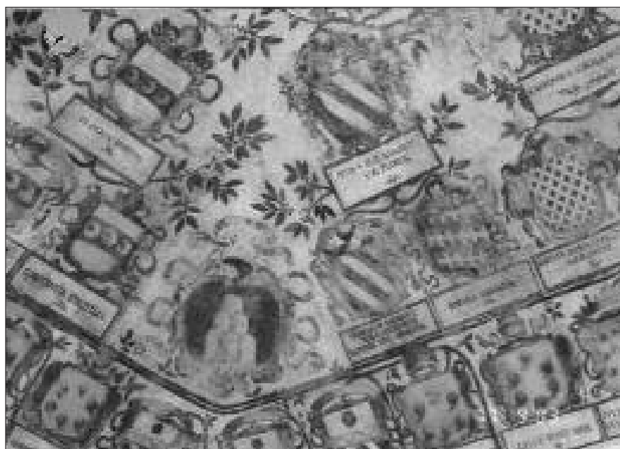
Fig. 9 – ANCORA UNA VISIONE PANORAMICA DELL'INSIEME ARALDICO DELLA VOLTA, QUI NELL'ANGOLO FRA LA PARETE DI NORD-OVEST E QUELLA OPPOSTA ALLA CONTROFACCIATA (SUD-OVEST)
